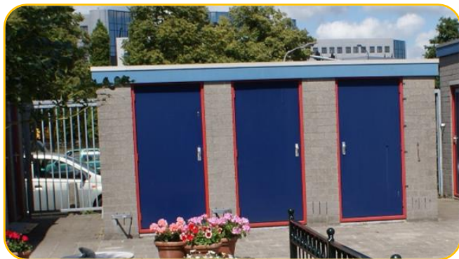
Losstaande bergingen en één van de hekken
